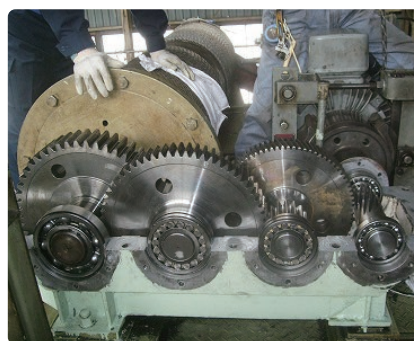
減速機開放点検
